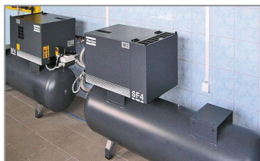
Fig. 3.1.7. Scroll compressor
